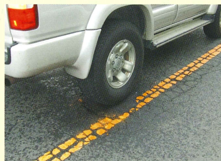
④通過車両にて転圧
