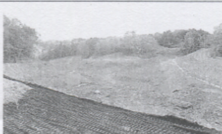
ReiFLEXが開業させる残土などの処理施設。出雲市小境町
