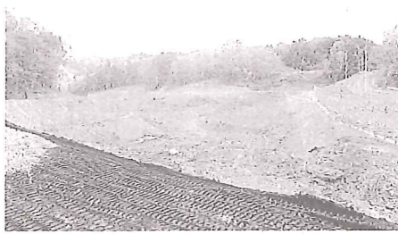
ReiFLEXが開業させる残土などの処理施設。出雲市小境町
